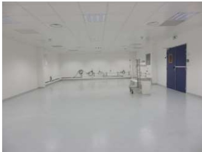
Réhabilitation de la salle robotique
