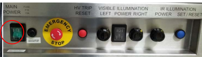
Fig.8 : mise en route machine
