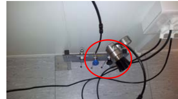
Fig.5 : ouverture des vannes
