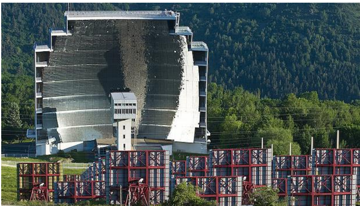
Figure 39: Four solaire d'Odeillo (1mégawatt) [39]
