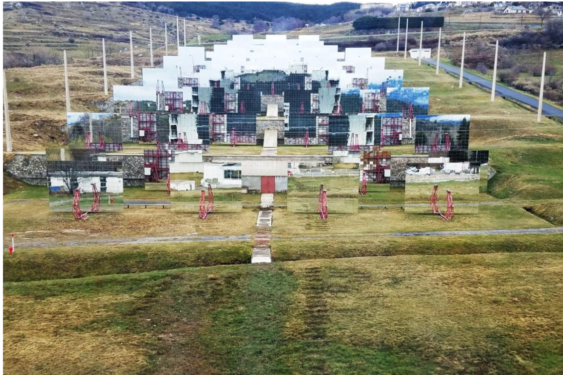
Figure 40: Champ d'héliostats mobiles du four solaire d'Odeillo
