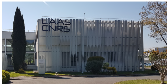
FIGURE 1.2 – Photo du bâtiment d'accueil du LAAS-CNRS
