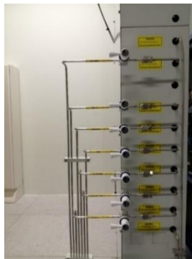
Figure 8 : Réseau des vannes de gaz
