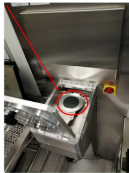
Figure 17 : Sas de chargement et dechargement
