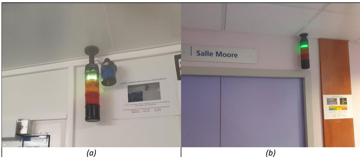
Figure 1 : Tours lumineuses dans le sas de la salle blanche (a) dans le couloir (b)
