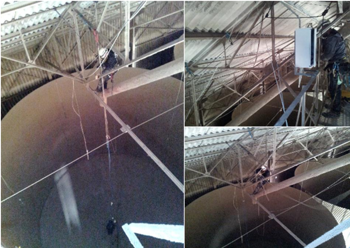
Figure 77 : Installation de la sonde SILOTEST 3
