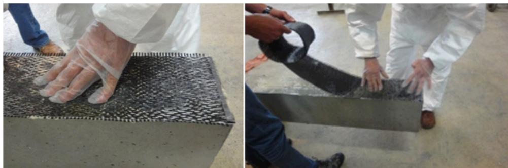
Figure II. - 10 (a) détail du matériau en TCF (b) déroulage du matériau pour collage avec résine
