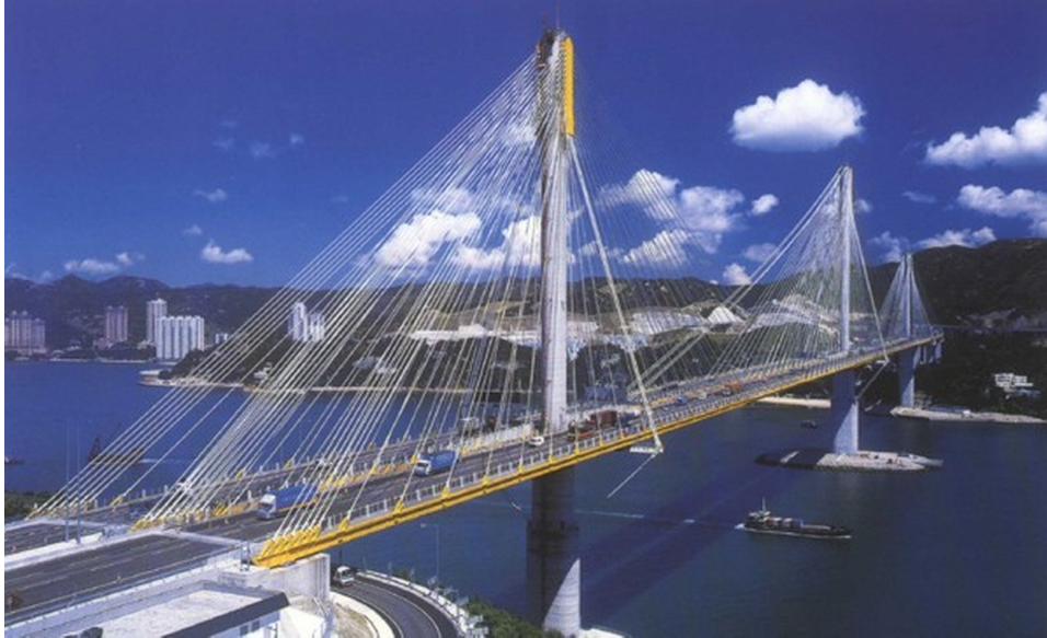
Figure I. 5 : Le pont « Ting-Kau » à Hong Kong
