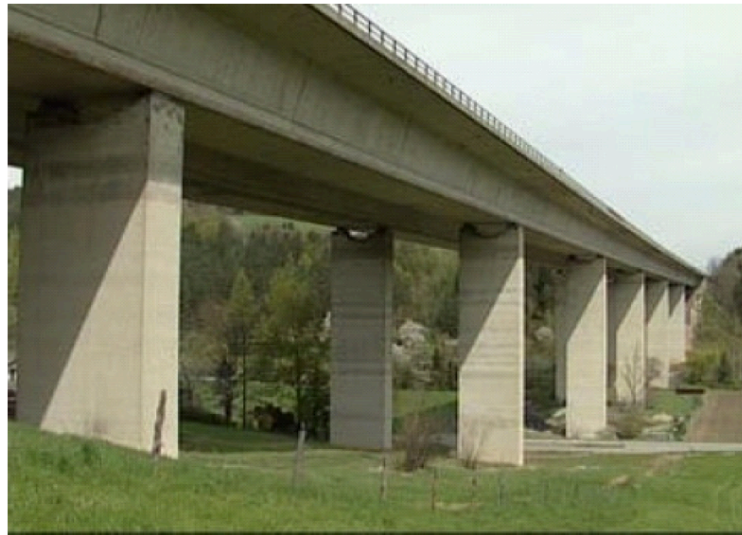
Figure I. 6 : Le pont « Warth Talübergang », Autriche
