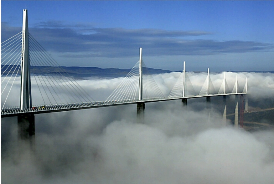
Figure I. 8 : Viaduc de Millau
