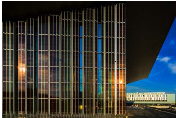
Figure 58. Bâtiment de l'Ecole Polytechnique Fédérale de Lausanne couvert de panneaux en cellules de Grätzel. Photo : ©Fernando Guerra [146].
