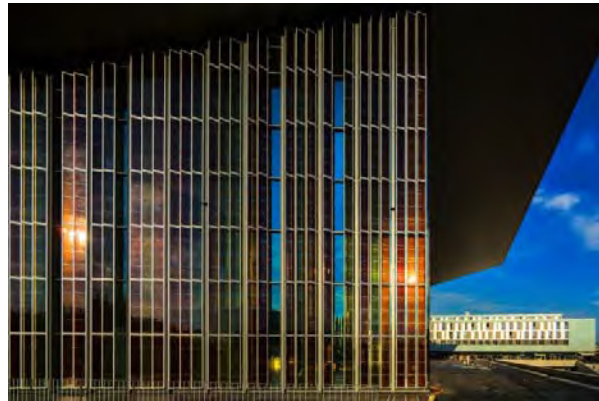
Figure 58. Bâtiment de l'Ecole Polytechnique Fédérale de Lausanne couvert de panneaux en cellules de Grätzel. Photo : ©Fernando Guerra [146].
