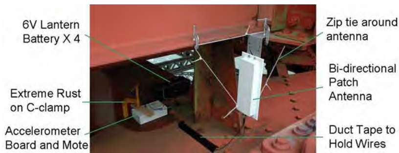
Figure 9. Un des 51 accéléromètres placés sur le Golden Gate Bridge à San Francisco pour surveiller les contraintes sur la structure du pont [22], [27].
