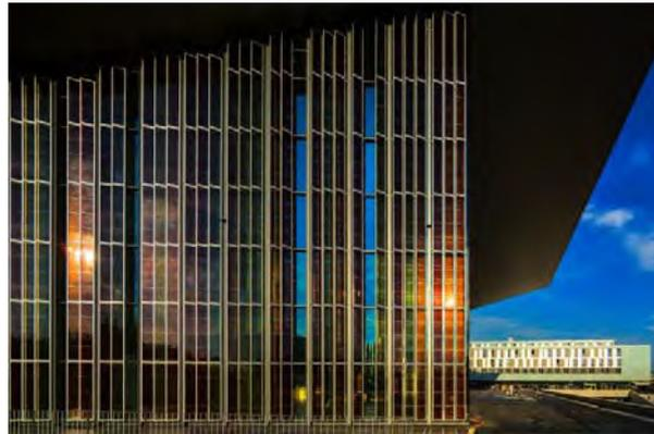
Figure 58. Bâtiment de l'Ecole Polytechnique Fédérale de Lausanne couvert de panneaux en cellules de Grätzel.
