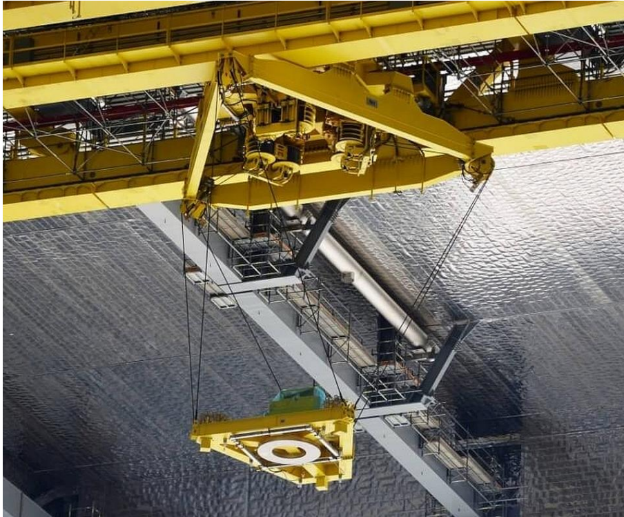
Figure 1.11 – Le RPC Tensile Truss du NIST dans la centrale nucléaire de Tchernobyl [6]
